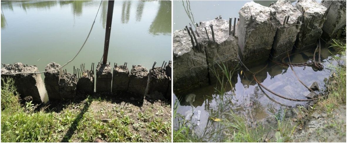
Рисунок 2.30 – Свайное укрепление берега
