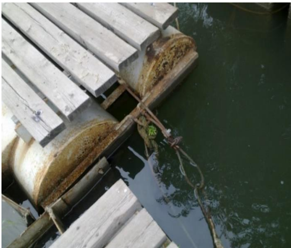
Рисунок 2.28 – Коррозия металла
